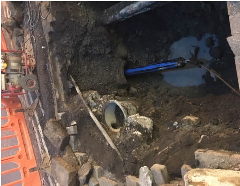
Ag sciorrlíneáil an phíobáin 125mm trí phíopa aispeist 200mm ar chosán in aice le cosán oifig an phoist.
