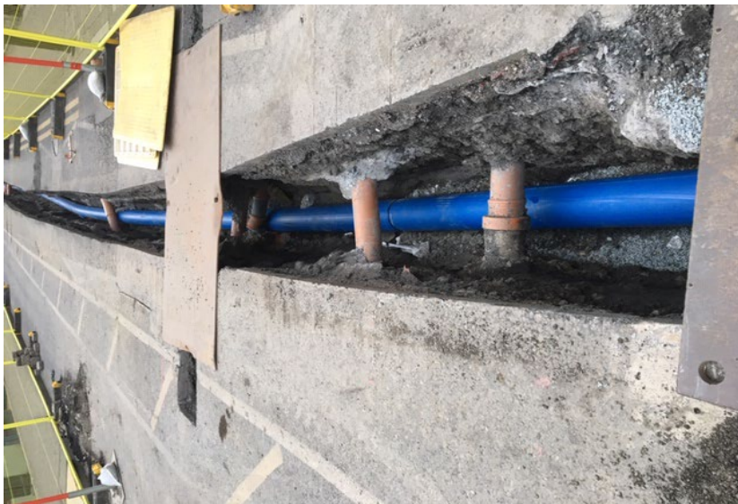
Phíopa 250mm i dtrínse curtha in áit, thíos faoi go leor Seirbhísí Fóntais
