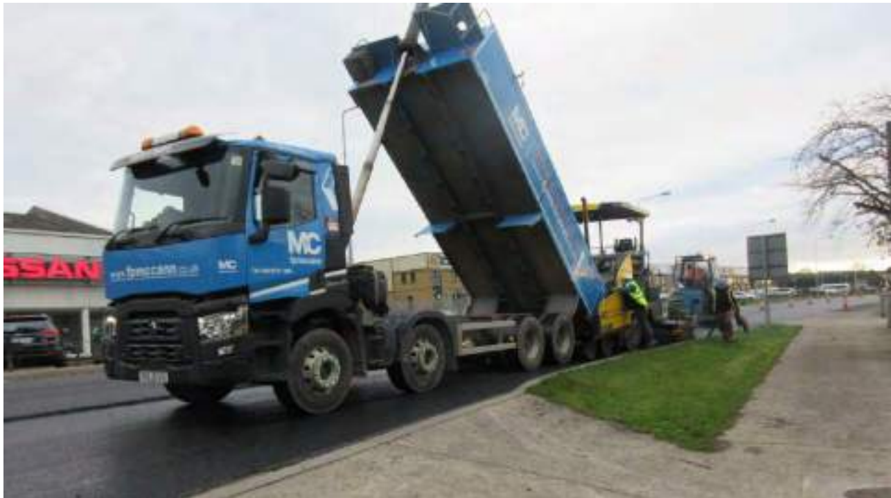
Grianghraf a léiríonn oibreacha dromchla ar an N55 ó Eochail go Tuaisceart Bhéal Átha na nEach – An Scéim Forleagtha Cosán
